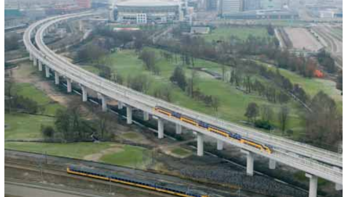
De Utrechtboog bestaat uit twee losse bogen in betonnen bakken en bevat in totaal 88 duizend kuub beton, honderd kilometer funderingspalen, 29 duizend dwarsliggers en 25 kilometer spoorstaaf. De bouw heeft 100 miljoen euro gekost. Foto's: De Jong Luchtfotografie
