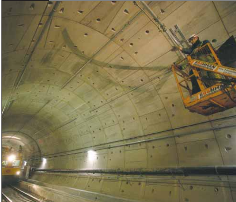
OM TE VOORKOMEN dat de aanleg van de Betuweroute vertraging oploopt werd gisteravond gewerkt aan de bovenleiding in de tunnel onder het Pannerdensch Kanaal. Het nachtwerk is noodzakelijk om op de lijn te kunnen rijden met een testtrein.
